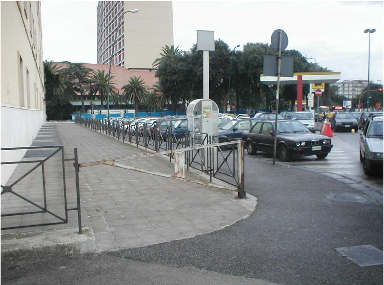
(Foto 10) La rampa è ottima ed anche con balaustra , ma sbarrata . Essa sarebbe finalizzata a garantire l'accessibilità in un sito di estrema importanza , delicatezza e gravità , qualora un cittadino disabile lo necessiti con urgenza e magari riservatezza .
