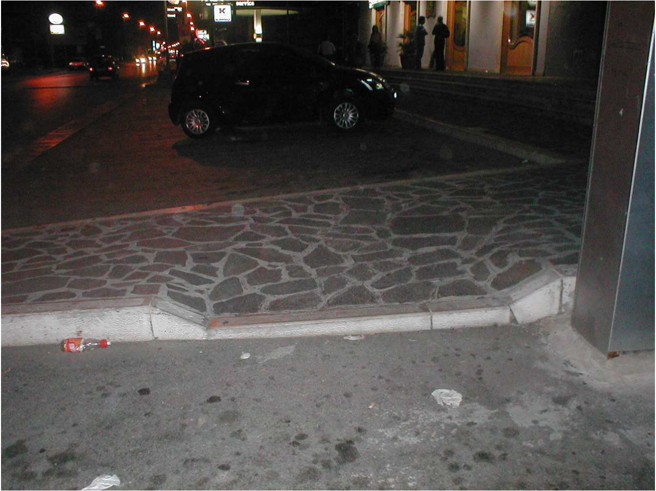
(Foto 15) Le caratteristiche sono identiche alla foto 8 , ma in compenso il marciapiedi è elegante , grazie al bordo in travertino crea quel gradevole distacco cromatico con le lastre in porfido e risalta perfettamente il gradino stilizzato. La composizione dimostra che il progettista è dotato di ottimo “ gusto delle b . a . , complimenti ”!.....
