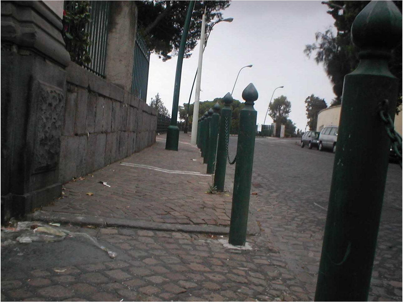
( Foto 4 ) Su di un marciapiedi dove si è già intervenuto per rimuovere le b . a . , dopo qualche metro dall'imbocco della rampa il percorso finisce lì....Infatti un palo dell'illuminazione ostruisce il passaggio anche per la presenza parallela di paletti e catene laterali. Un evidente caso di accessibilità priva di visitabilità e fruibilità per mancata sistematicità .
