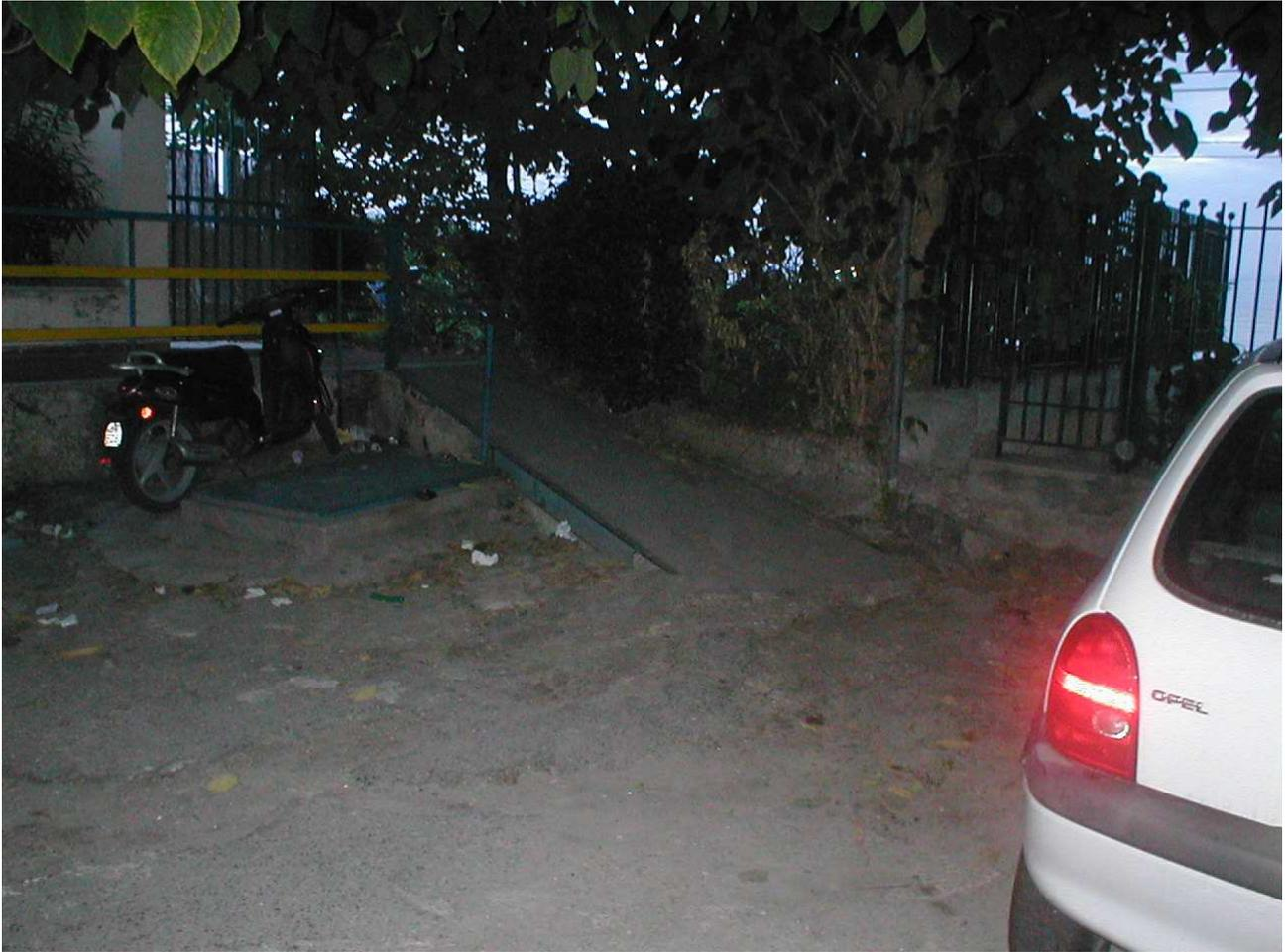
(Foto 11) Questa rampa , appartenente ad una struttura pubblica , evidenzia uno stato di deterioramento nella parte estrema più bassa con un dislivello irregolare .Ciò determina situazioni sostanzialmente assimilabili alle foto 8 e 9 con l' aggiunta dell' aggravarsi del fenomeno e con il paradosso che la rampa in sé *non è tanto male* .
